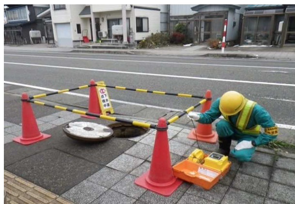
マンホールの点検
