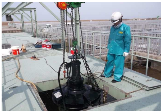
処理施設の点検
